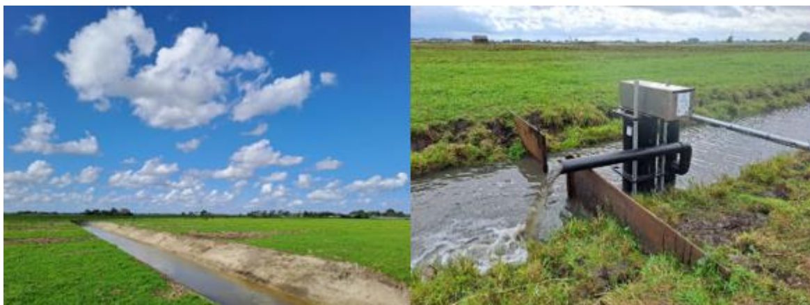
De nieuw gegraven sloot en geplaatste pomp in de Lage Hoek
